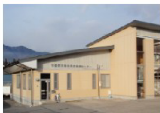
堀金学校給食センター
